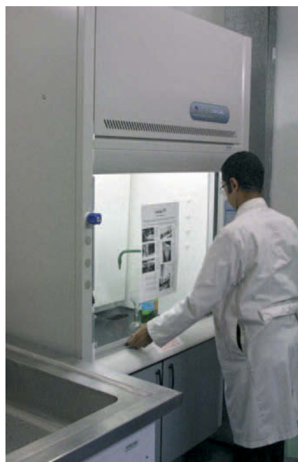
Le nouveau conduit de fumée utilisé dans les traitements chimiques.
