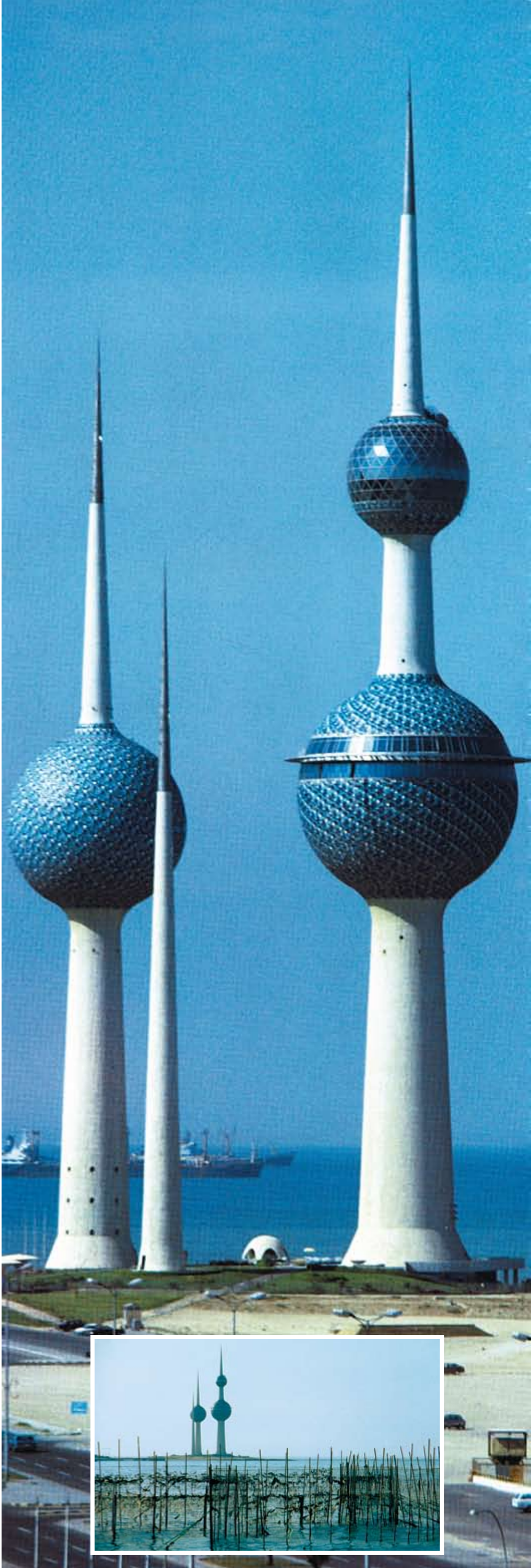
أبراج المياه Water Towers
