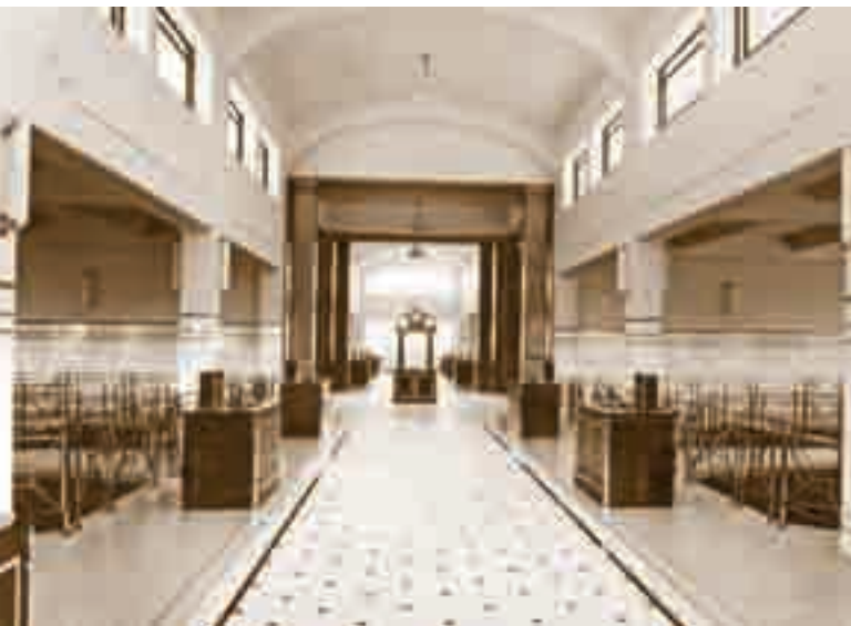
صالة تريبازات تشغيل المرشحات بالدور الأول بمبنى المرشحات
