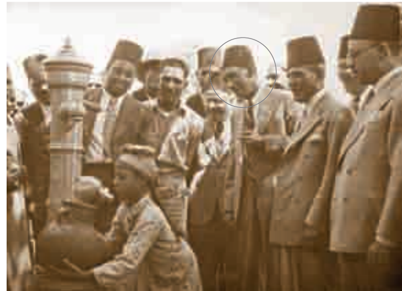
تجربة عملية لعمل المحطة ونقاء المياه
