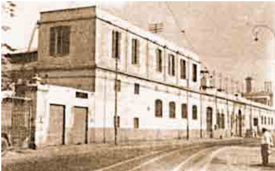
(أشكال ٤٩، ٥٠) المبنى القديم لمطبعة بولاق حيث يظهر لنا الواجهة المظلة على حي بولاق.
