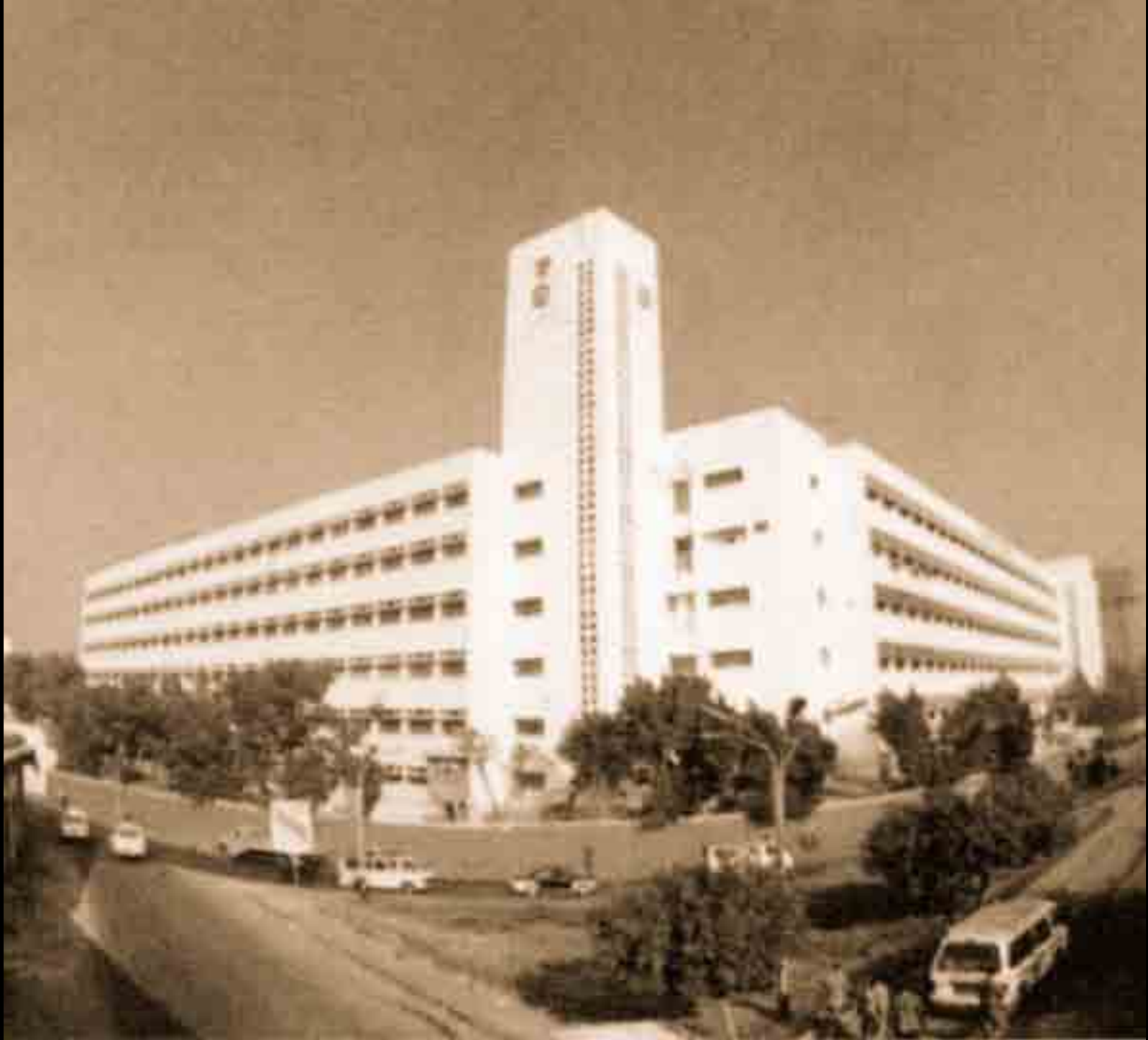
(شكل ٥١) المبنى الحالي لمبنى المطبعة الأميرية بحي إمبابة
